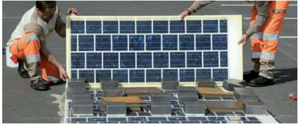
Fransa, 1.000 KM Asfalt yola güneş paneli döşeyip 5 milyon kişinin elektrliğini sağlayacak projeyi hayat geçirdi
